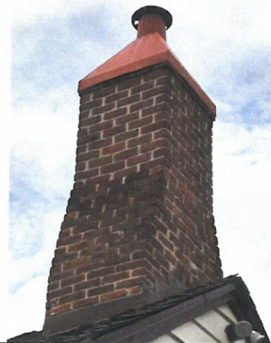
Photo 29. Area A, Chimney A.
